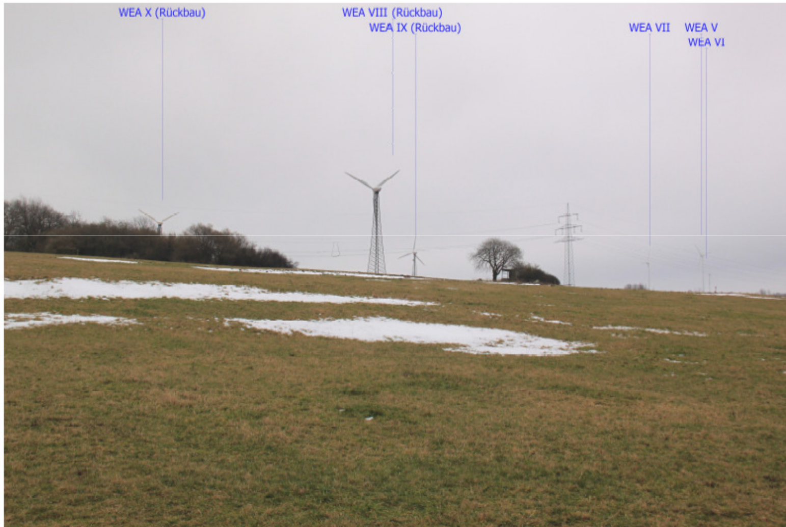
Foto 21: Fotostandort 11 – Blick vom Ortsrand Oberdreisbach in Richtung der bestehenden WEA
